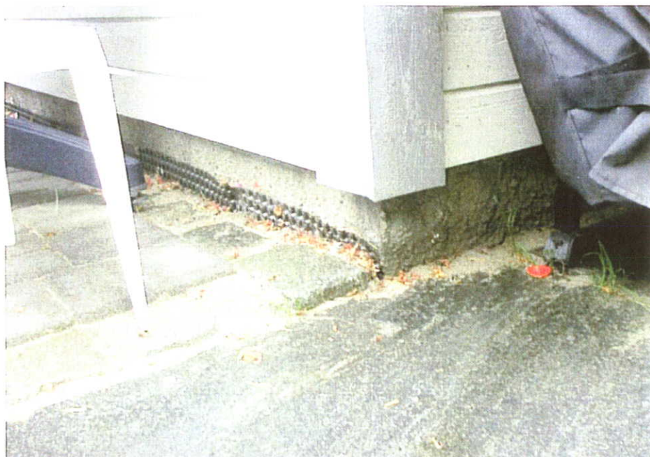
Foto 2: Grunnmurssystemet utvendig, bildet er fra Bilittkroken 48, Oslo.
