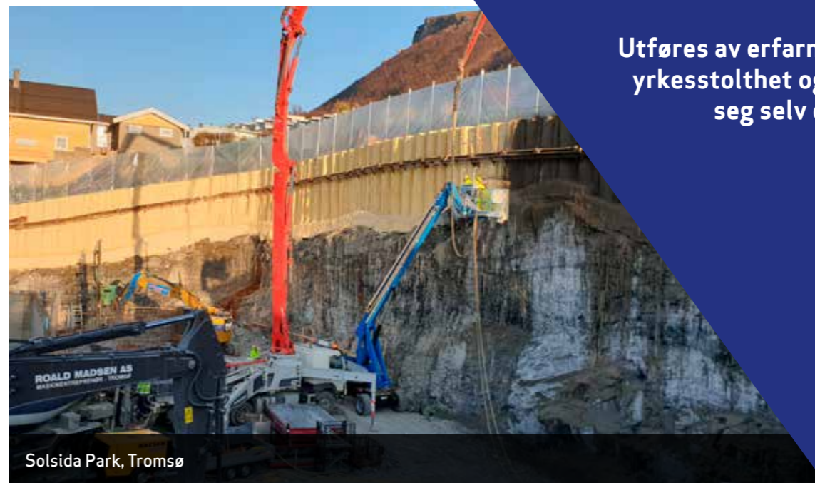
Sprøytebetong til jordnagling
